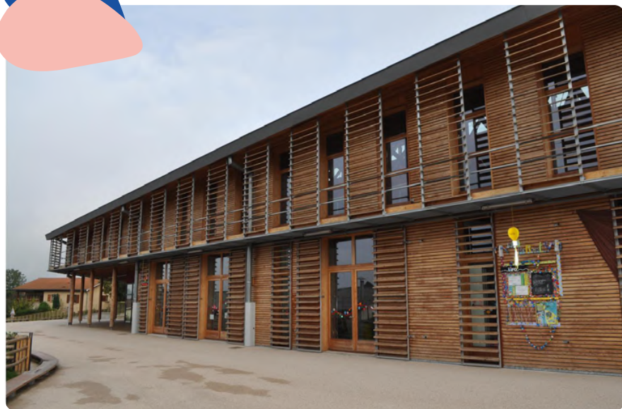
Le bâtiment en bois qui abrite le restaurant scolaire de Saint-Martin-en-Haut (© arborescence-concept.com)
